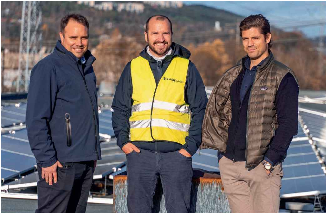
Overtakelsesbefaringen på Professor Birkelands vei 36 med solcelleleverandør (Sunday Power). F.v. Torgeir Håvim Nilsen (Driftssjef i Eiendomsspar), Kjetil Laupa Steine (Prosjektleder i Sunday Power) og Bjørn André Søntvedt (Teknisk sjef i Eiendomsspar)
