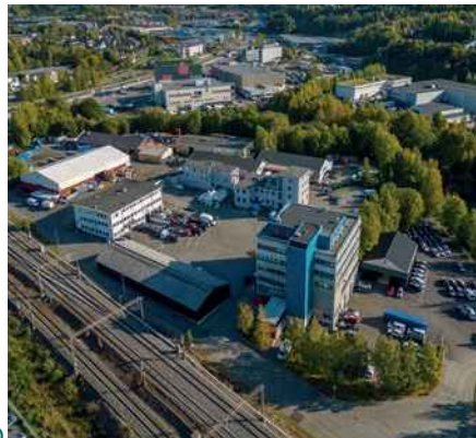
1) Alna Park (Strømsveien 221-223 og Breivollveien 13), 12 900 kvm
