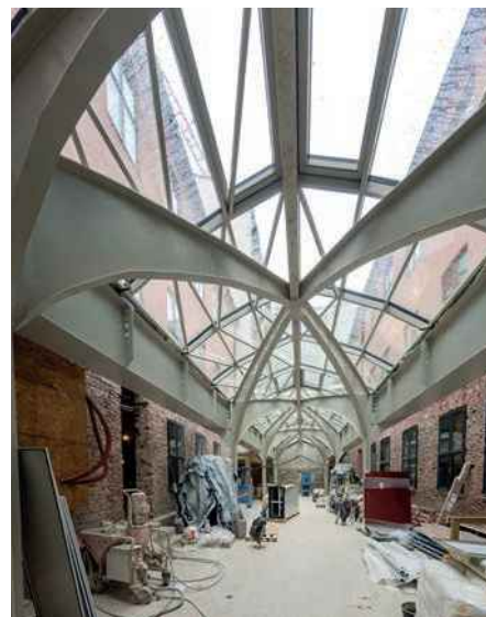
Spennende atrium som kommer i første etasje
